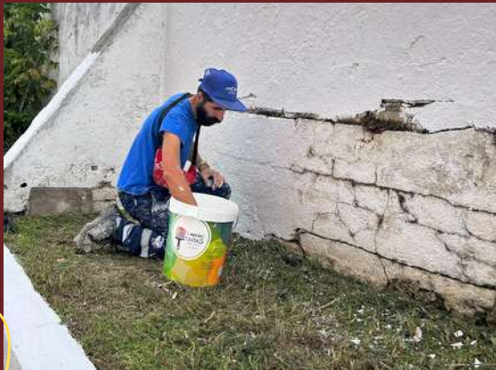
Manutenção e limpeza dos muros do Cemitério Paroquial
