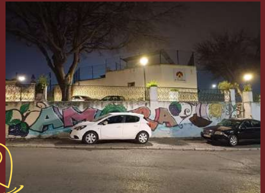
Colocamos iluminação LED na Pcta José Maria Vinagre
