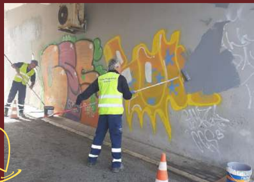
Pintamos o túnel da R. Joly Braga Santos (Qta Batateiro)
