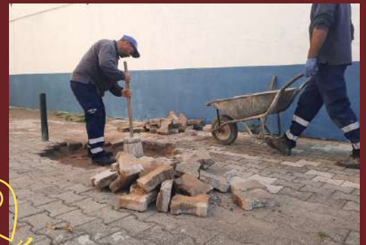
Reparamos o pavimento pavê na Pcta Estevão Amarante (Medideira)
