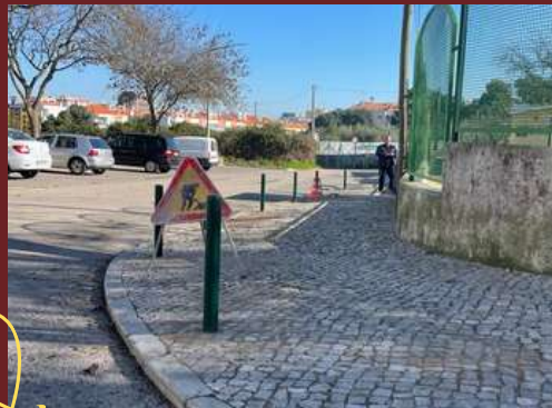
Colocámos pilaretes junto à EB1 Qta das Sementes
