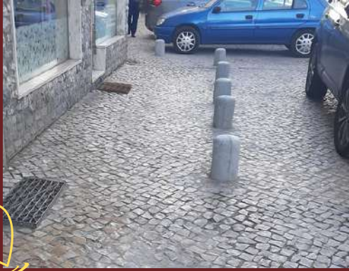
Colocámos pinos na Rua do MFA
