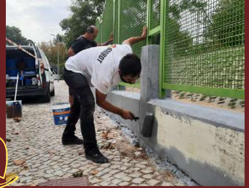
Pintámos e arranjámos o muro da EB1 Paivas
